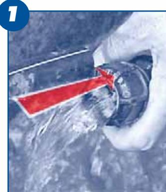
L'assemblage est tellement simple que vous pouvez même travailler sur une conduite sous pression. Couper le tuyau d'équerre et aligner le raccord préassemblé.
