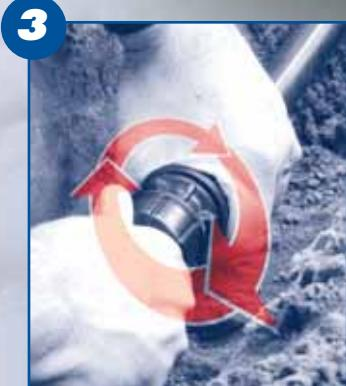
Serrer l'écrou à la main, puis fermement à l'aide d'une clé.
